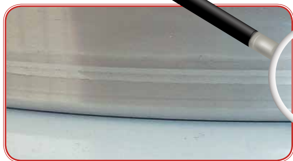
Сварные швы днища и обшивки, выполненные методом TIG
